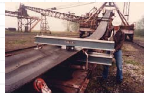
Reparación en el sitio
